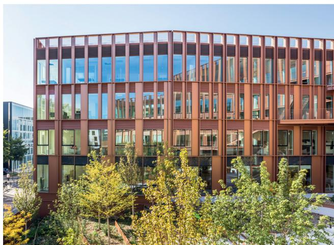
Structure aluminium de teinte cuivre, formée de réglés verticaux rythmant les pliages créés.
