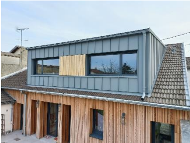
Modification d'une lucarne sur une habitation réalisée en aluminium et isolation biosourcée. Reims (51) ©POINTILLART-PITIOT
