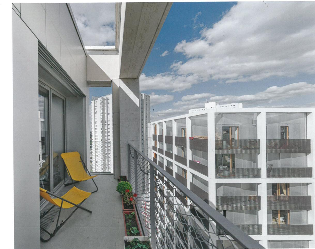
Prägnante, außen liegende Betontragwerke und umlaufende Balkone gliedern die Hochhausfassaden. Die „Füllung“ der großen Regalstrukturen besteht aus Metallblech und Lärchenholz.
