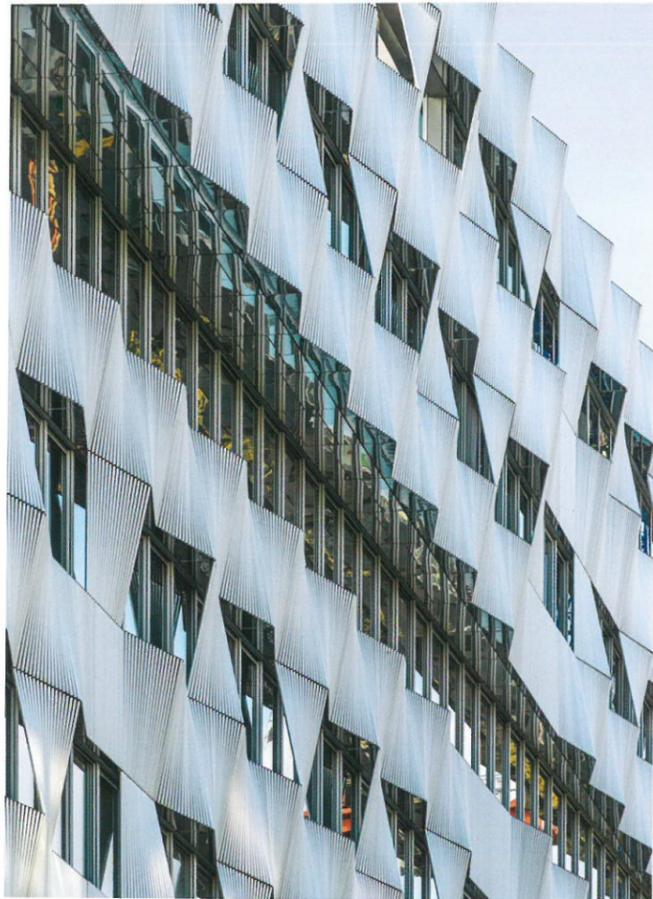
Wie eine zweite Haut liegen die vertikal und diagonal in quadratischen Modulen montierten, silbern eloxierten Aluminiumröhren vor diesem Pariser Bürogebäude des Architekturbüros Brenac & Gonzalez. Die Kombi-
