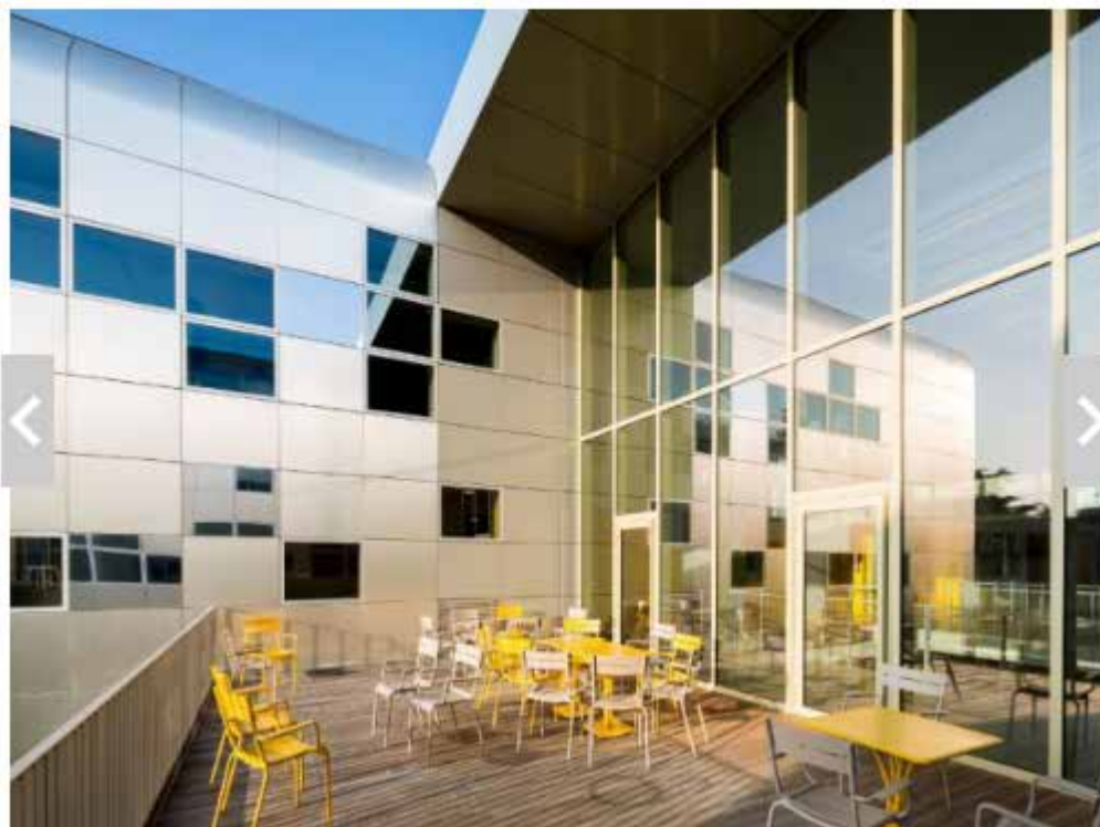
Le nouveau bâtiment du CHU de Poitiers réalisé par l'atelier Brenac+Gonzalez © Sergio Grazia
